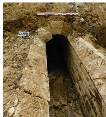
> Fig. 2 : Égoût ovoïde maçonné, en fonction depuis le milieu du XIX<sup>e</sup> siècle, quadrillant l'emprise.
