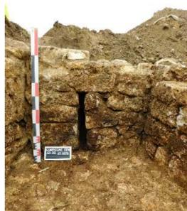
> Fig. 4 : Dans l'épaisseur du rempart, une meurtrière (en haut à gauche) a été bouchée et transformée en latrines, Place d'Armes.
