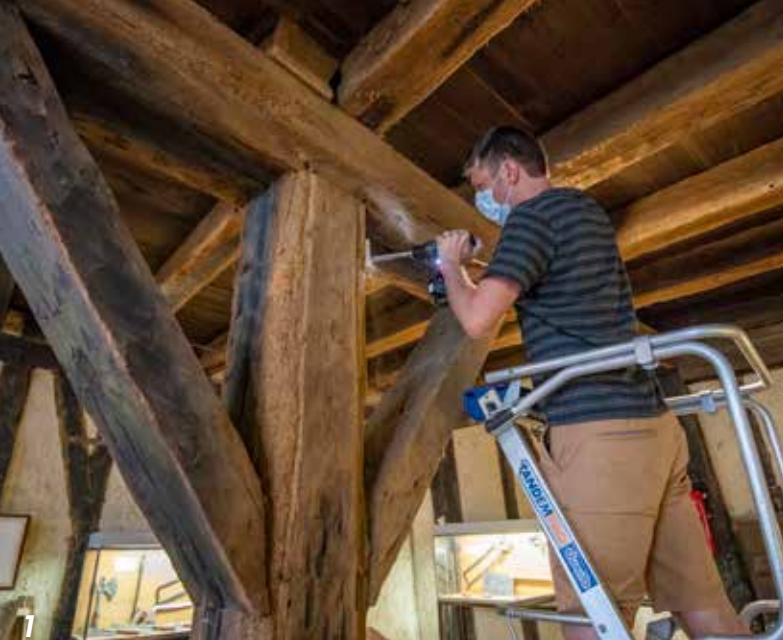
Fabien Cerbelaud est en train de procéder au forage d'une des poutres de la Maison de la Boucherie pour en extraire un prélèvement qui sera en suite analysé.
